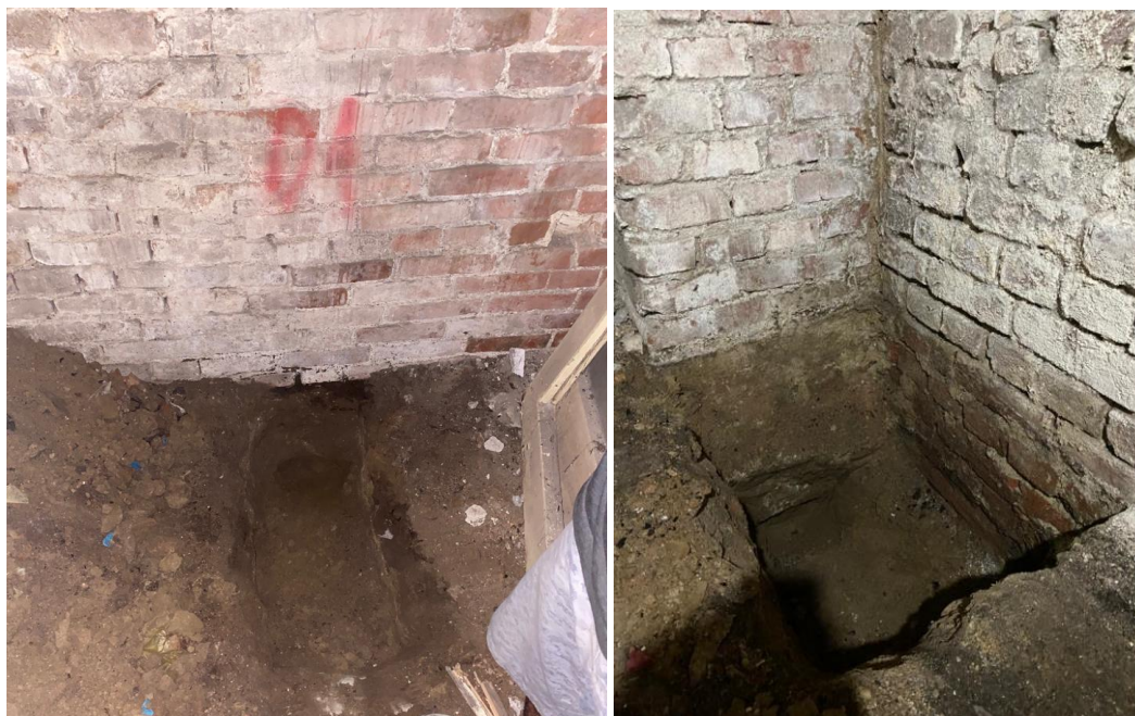
Figura 9. Fotografii din timpul realizării sondajelor de dezvelire: D1 (stânga) și D2 (dreapta)
